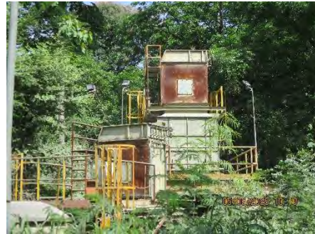
ภาพที่ 2-17 ระบบสายพานติดตั้งอุปกรณ์กำจัดฝุ่น บริเวณจุดโอนถ่าย
